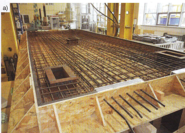
Rys. 4. Układ zbrojenia i sprężenia przed zabetonowaniem (a), płyta po zabetonowaniu (b)
