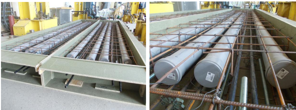
Rysunek 7. Płyty „kanałowe” pomostu wagi przed zabetonowaniem.
