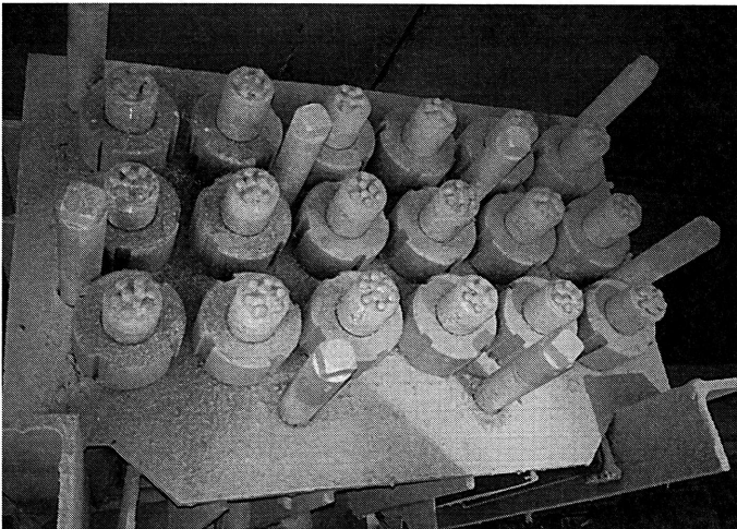
Rys. 3. Widok zakotwień czynnych przystosowanych do kontroli siły w poszczególnych kablach dźwigarów dachowych
