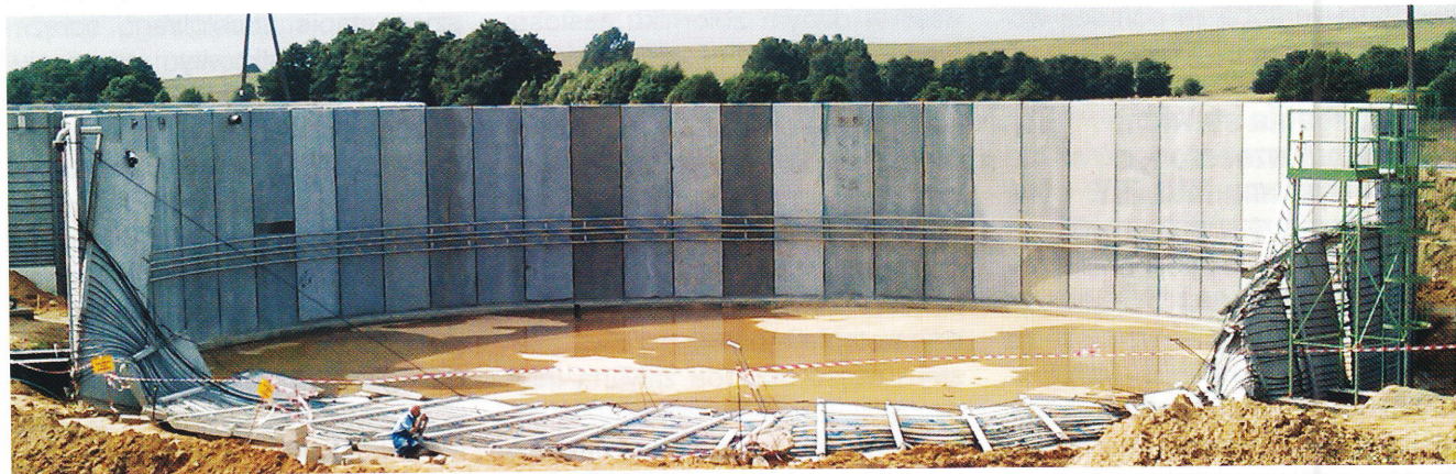
Rys. 2. Zbiornik nr 5 po katastrofie
