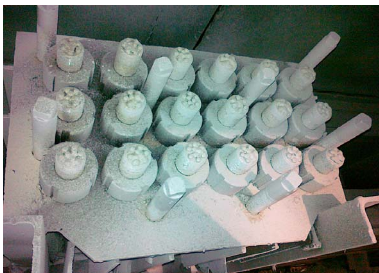
Rysunek 3: Widok zakotwień czynnych przystosowanych do kontroli siły w poszczególnych kablach dźwigarów dachowych
