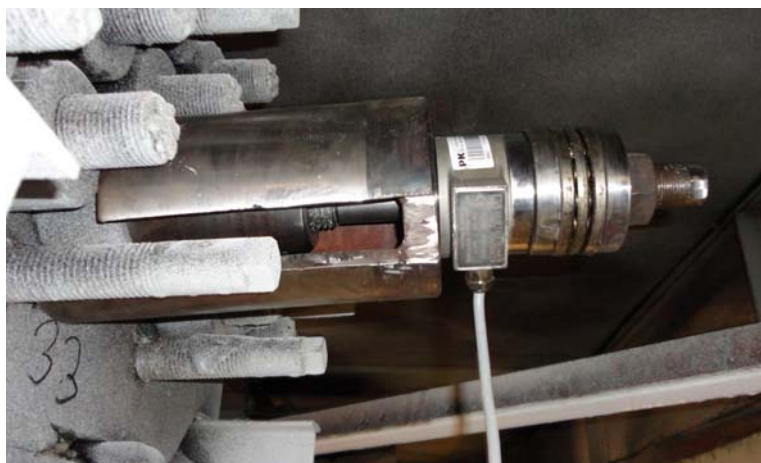
Rysunek 6: Widok zainstalowanych elementów pomiarowych na głowicy zakotwienia czynnego
